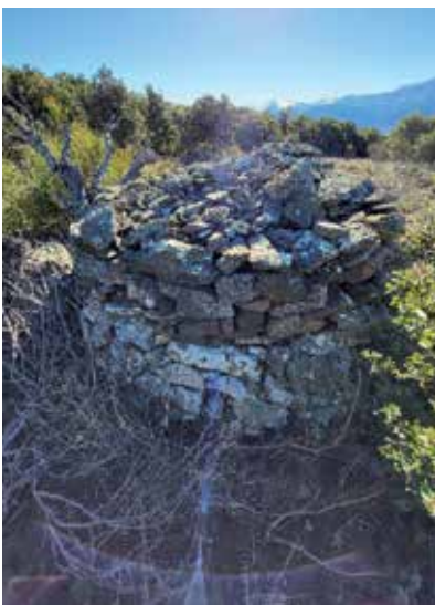
Photo 5 : Puit en pierre sèche, Arboussols
